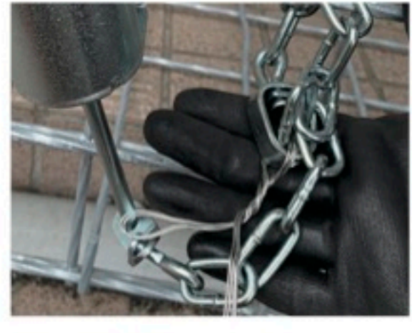
⑤ ステンレス線を使い、本体を固定します。
