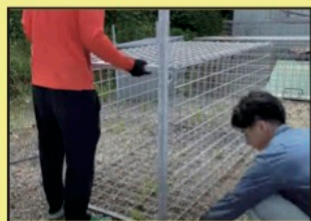
④扉シャッターを取り付ける
