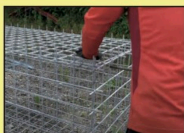
②専用曲げ棒で飛び出たワイヤーを曲げる
